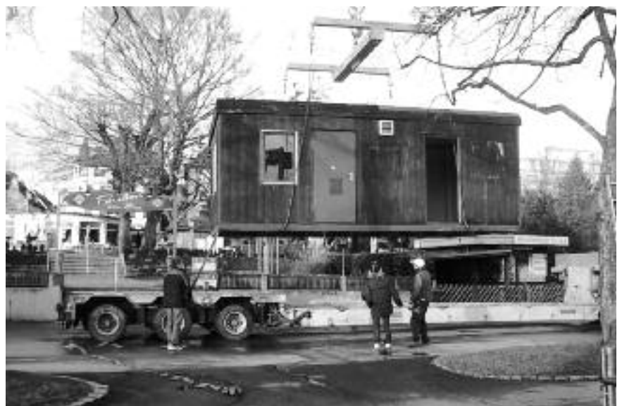
Millimetergenau wird der alte „Container“ abgesetzt.
