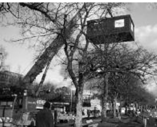
Einige Tonnen Hafenmeisterbüro schweben über den Wipfeln...
