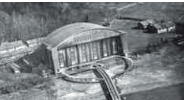
Luftaufnahme 1924 von der großen Flugboot-Halle und den Baracken rechts oben.
