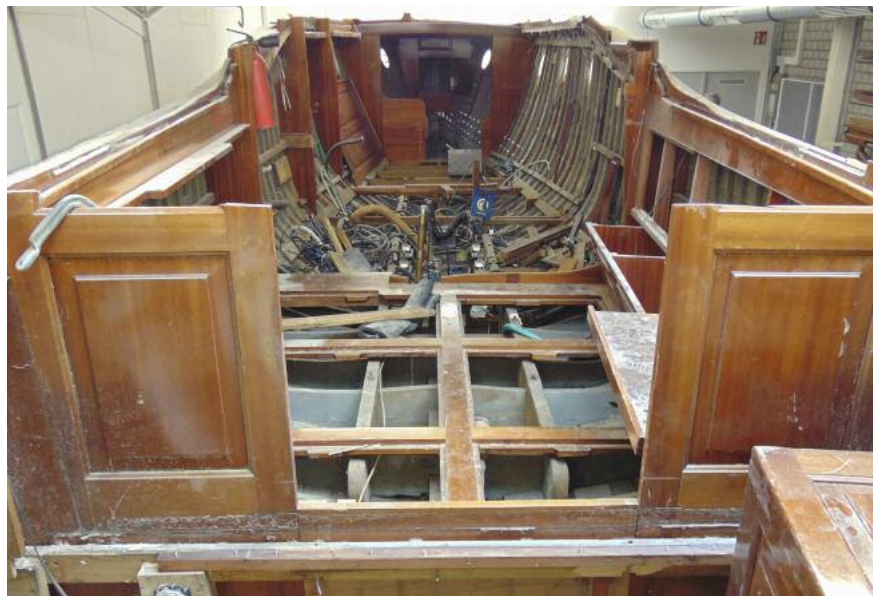
Baustelle Innenrumpf: Brauchbare Substanz in der ALTENRHEIN.
